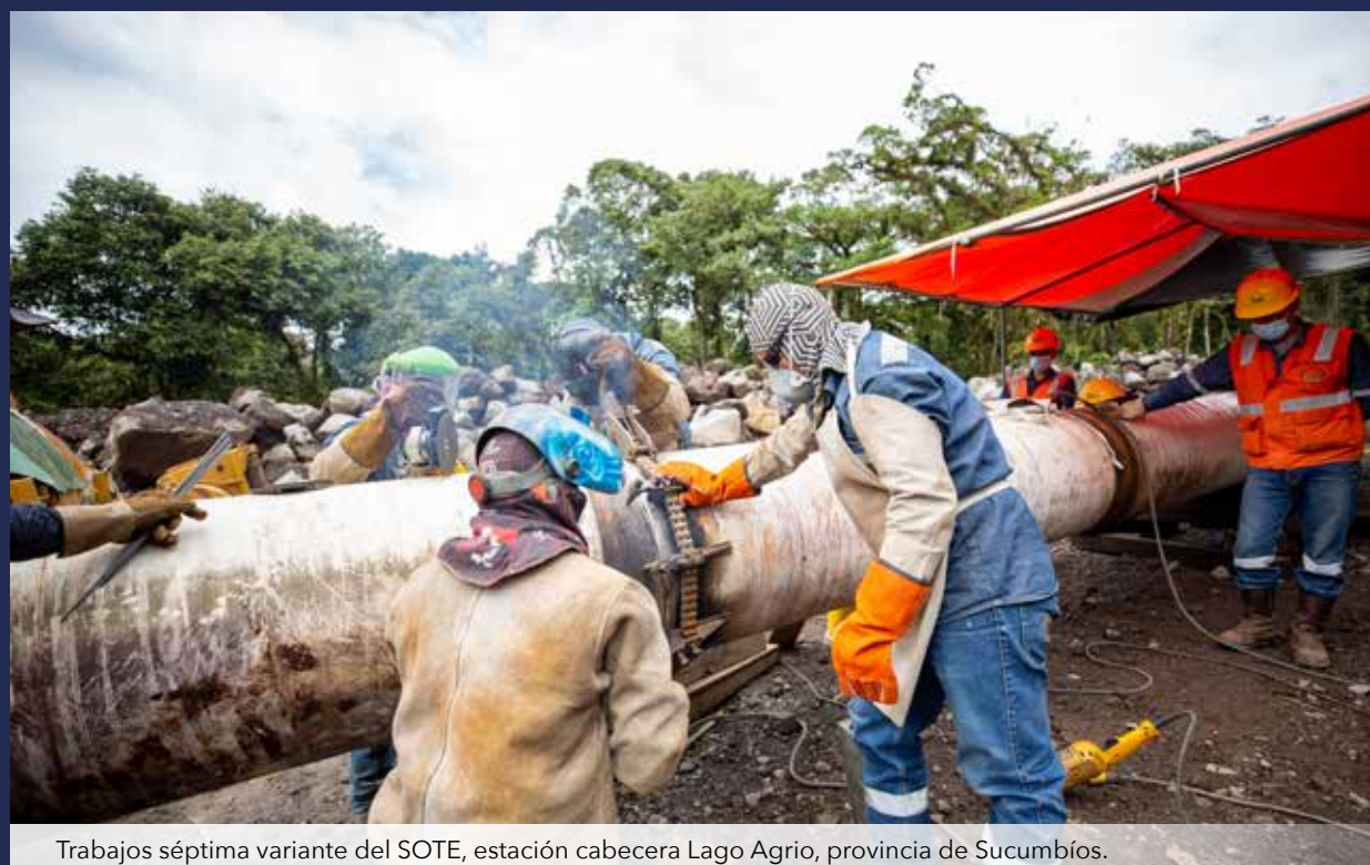
Trabajos séptima variante del SOTE, estación cabecera Lago Agrio, provincia de Sucumbios.
