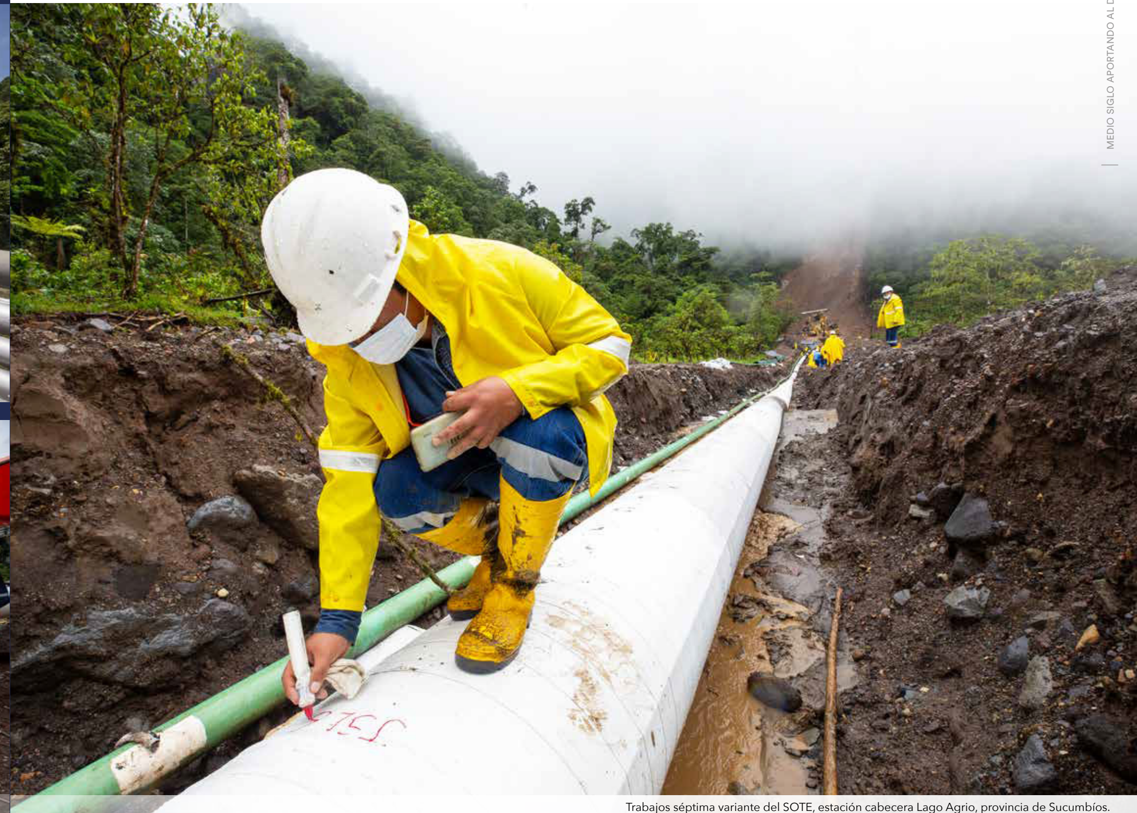
Trabajos séptima variante del SOTE, estación cabecera Lago Agrio, provincia de Sucumbios.
