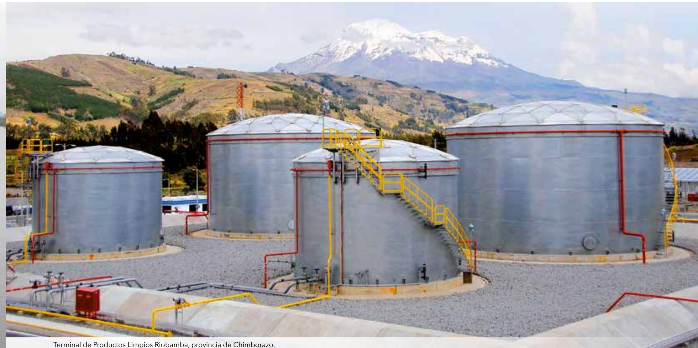
Terminal de Productos Limpios Riobamba, provincia de Chimborazo.
