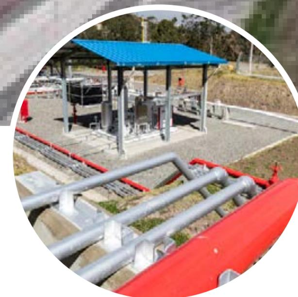
Todas las bombas son accionadas por motores eléctricos de velocidad variable. En cada una de las estaciones se ha previsto un Sistema de Control Centralizado, con el sistema de monitoreo por fibra óptica SCADA, desde el cual se puede monitorear, controlar y supervisar todas las actividades operacionales de la estación. Además, se puede visualizar las condiciones operativas de las otras estaciones.
