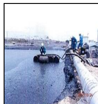
Colocación de mangueras para succión de agua
