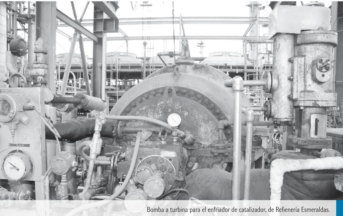
Bomba a turbina para el enfriador de catalizador, de Refinería Esmeraldas.
