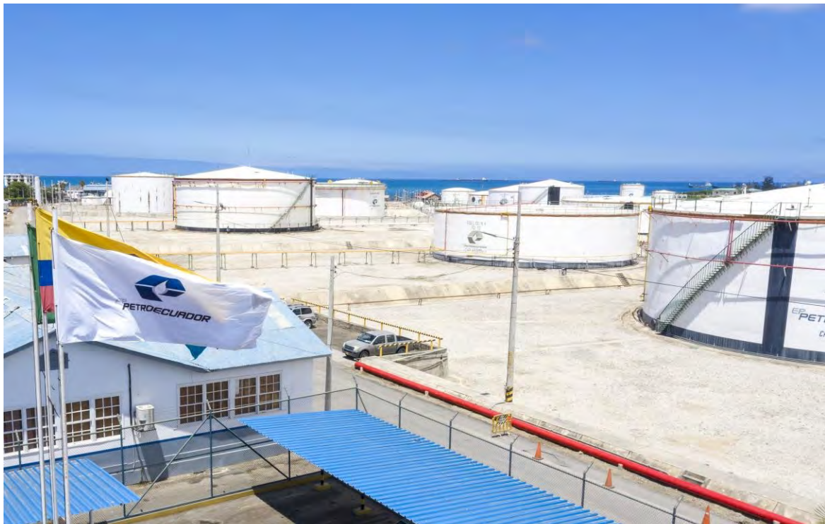
Tanques de almacenamiento de Refinería La Libertad, Santa Elena
