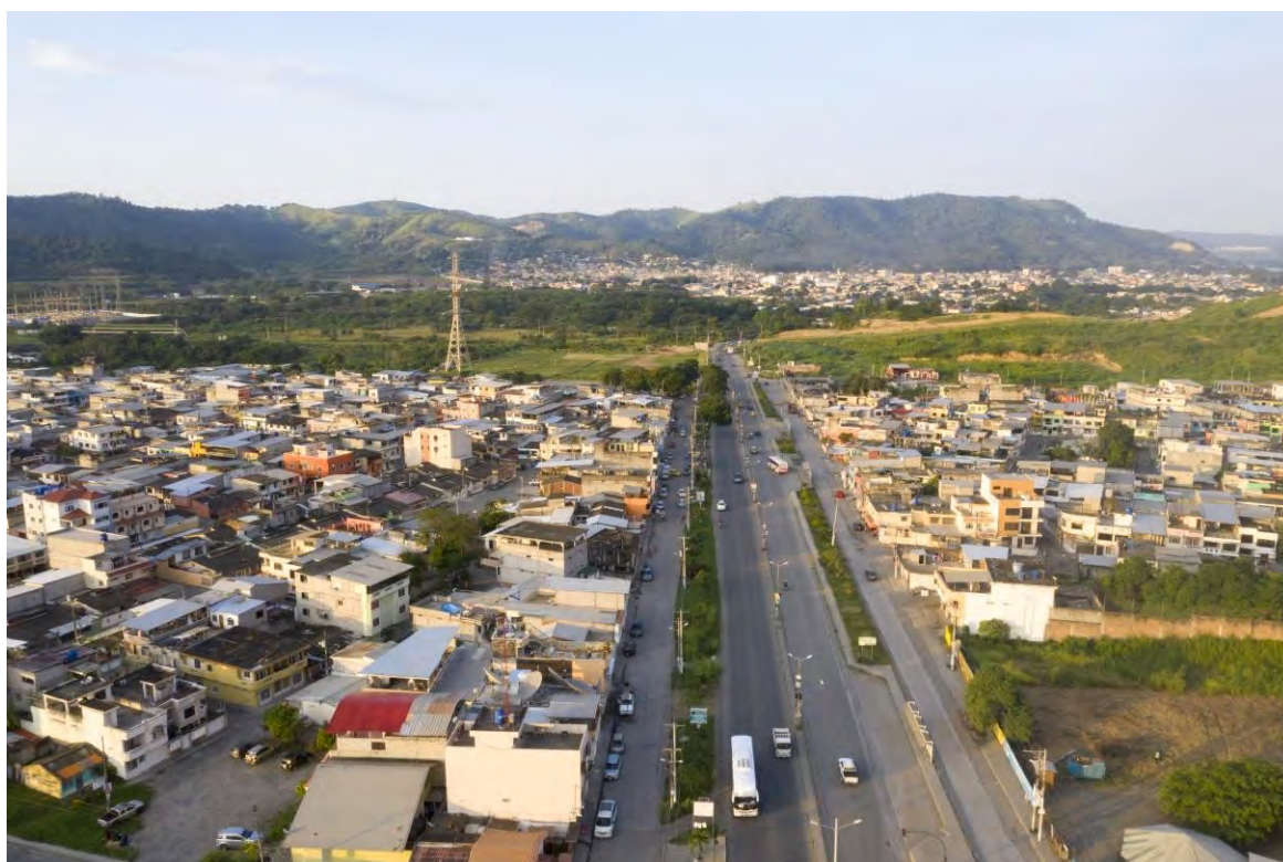
Construcción del anillo vial en la ciudad de Esmeraldas
