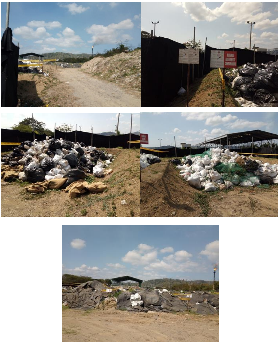
Figura 3: Área de almacenamiento de residuos, almacenados en suelo sin impermeabilizar y sin cubierta
