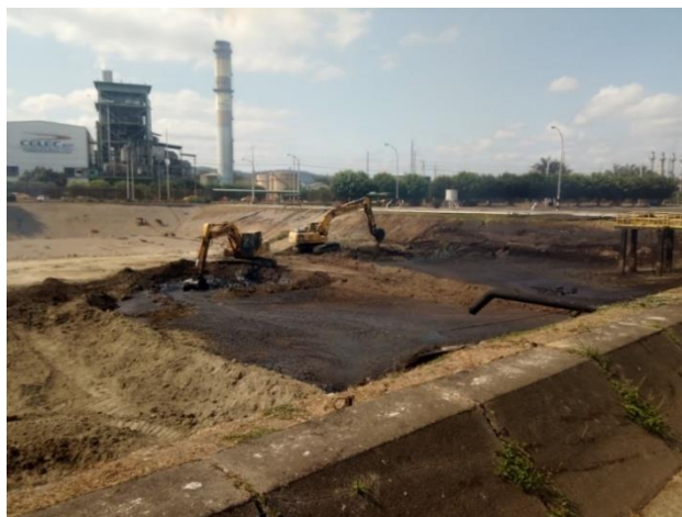
Figura 10: Piscinas de residuos de planta de efluentes líquidos. Proceso de extracción de tierras contaminadas de hidrocarburos para su posterior traslado a las áreas de tratamientos de bioremediación.
