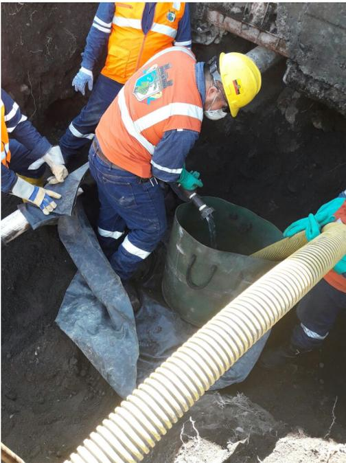
Luego de haberse detectado anomalías mediante Sonda Inteligente (equipo automatizado que recorre la tubería y reporta su estado), personal de Gerencia de Transporte de EP Petroecuador, procedió al cambio de tres tramos de la tubería PK 291-292, perteneciente al Poliducto Shushufindi-Quito, ubicado en el sector del río San Pedro (La Armenia-Pichincha).
