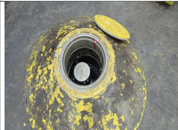
**Foto No. 59.** Válvula de carga para los tanque de combustible
