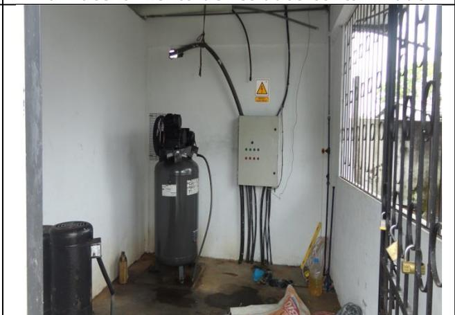
**Foto No. 36.** Tanque de compresión de aire
