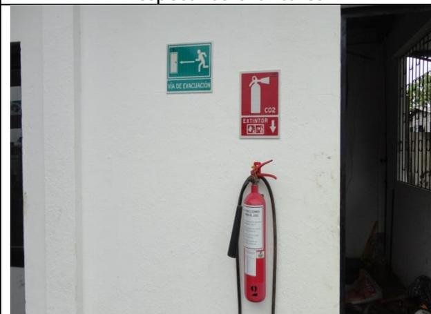
**Foto No. 35.** Extintor en el área de bombas para dispensadores
