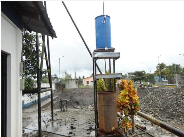
**Foto No. 71.** Tanques filtro de agua lluvia
