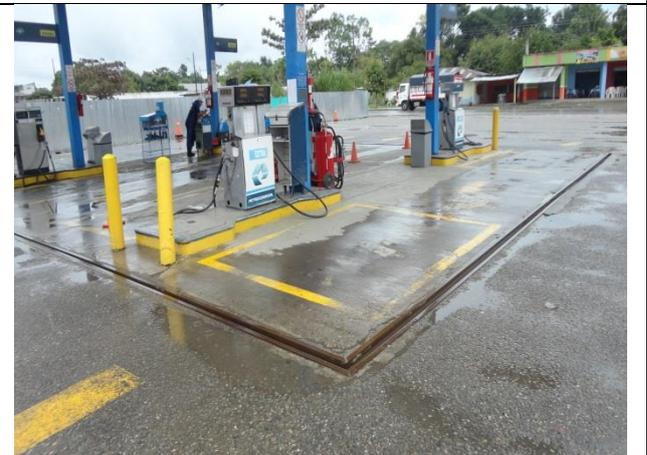
**Foto No. 46.** Canaleta de seguridad alrededor de la isla de despacho de combustible
