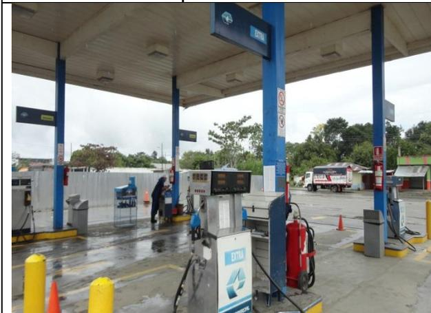
**Foto No. 45.** Extintor de 100lbs. En la isla de despacho de combustible
