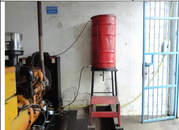
**Foto No. 41.** Tanque de almacenamientos de combustible para el generador eléctrico
