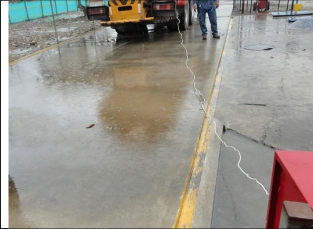
**Foto No. 61.** Conexión del autotanque a tierra
