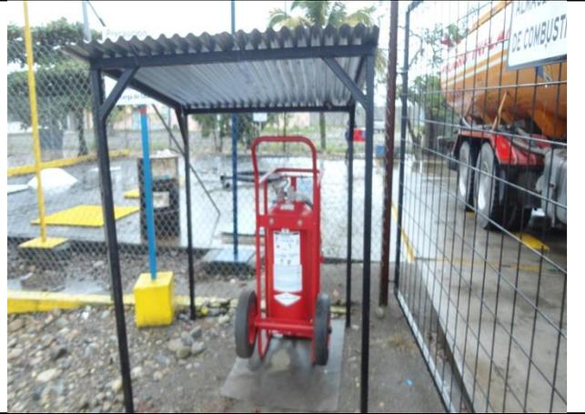
**Foto No. 56.** Extintor de 150lbs. En el área de recepción de combustible
