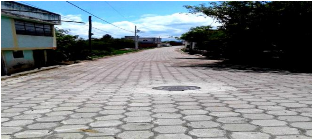
Alcantarillado Sanitario para la Comunidad de Calpiloma, cantón Riobamba, provincia de Chimborazo.
