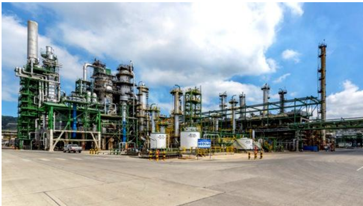
Refinería Estatal Esmeraldas
