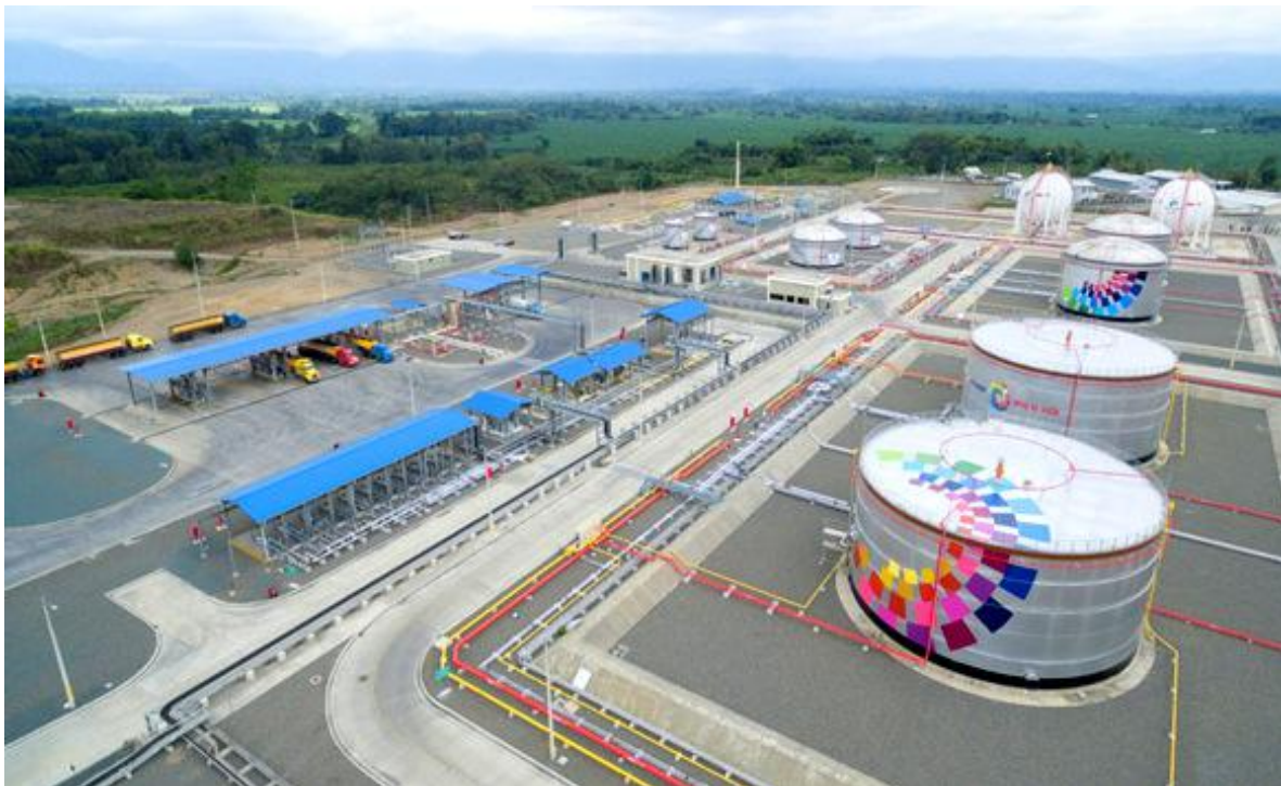
Terminal de Productos Limpios la Troncal
