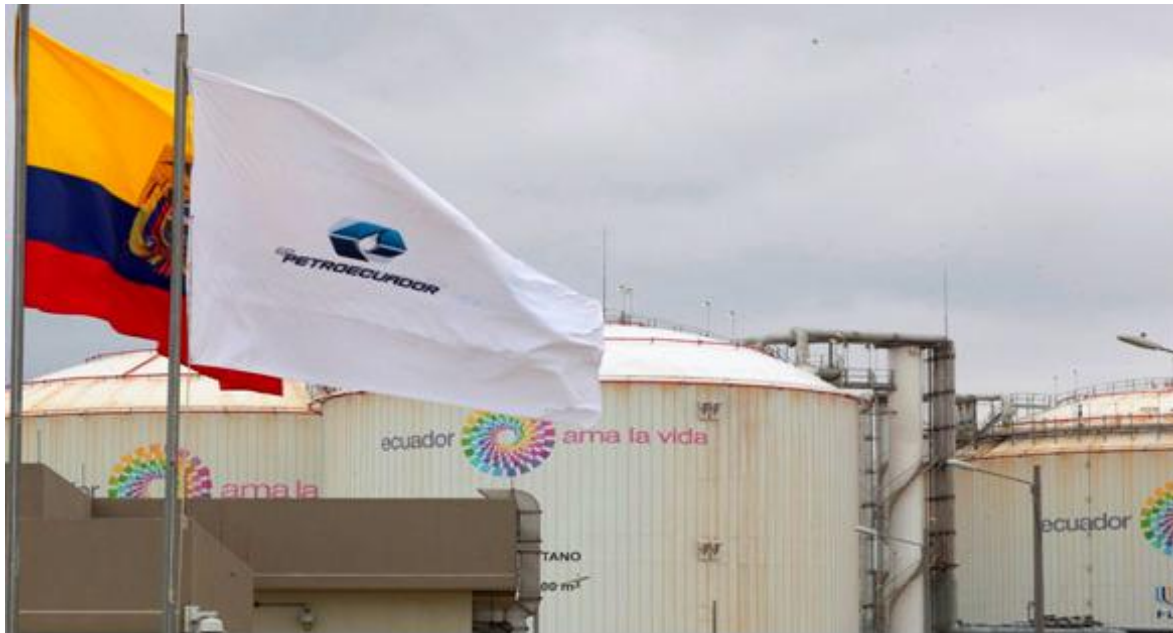
Tanques Estación de captación de gas el Chorrillo. Guayaquil
