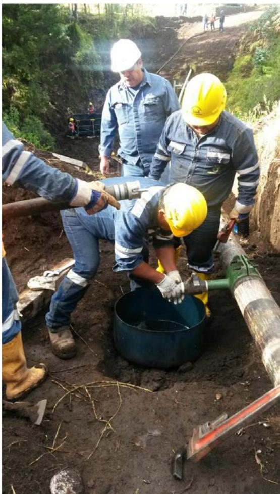
Técnicos de la Gerencia de Transporte de Petroecuador, efectúan un **cambio programado** en tres tramos de la **tubería del Poliducto Quito-Ambato**.
