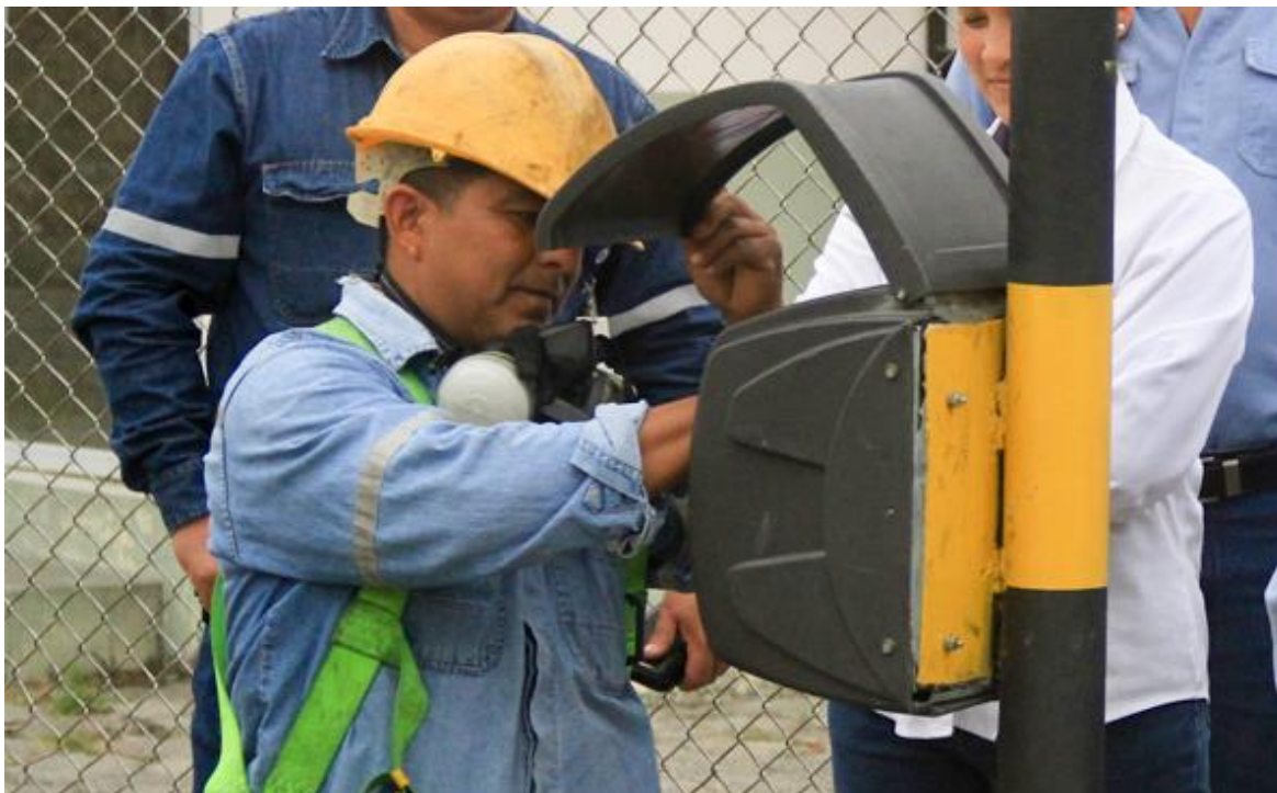
Operador de EP Petroecuador verifica sistema de automatización en Terminal Pascuales.
