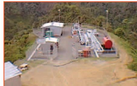
Las estaciones reductoras de presión cuentan con: sala de control, sistema de generación eléctrica, sistema contra incendios, sistema de comunicaciones y válvulas reductoras de presión.
