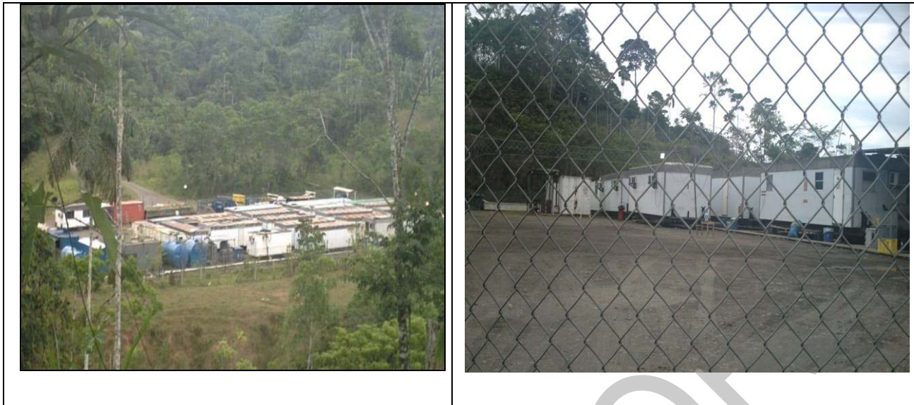
Foto 4- 5. Campamento base para el personal.
