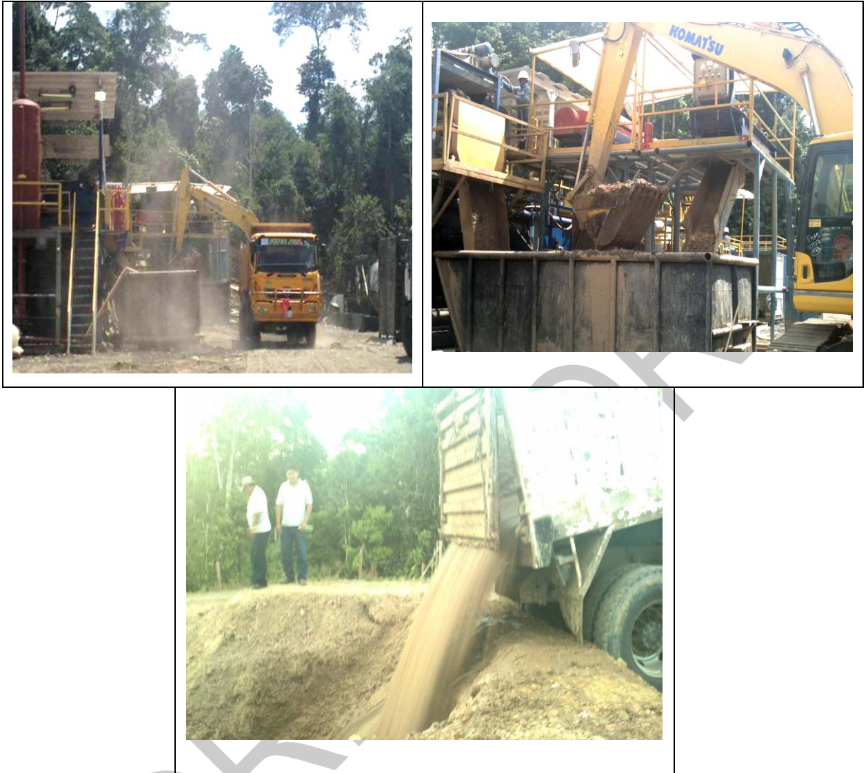
Foto 4- 2. Transporte y disposición de cortes de perforación.
